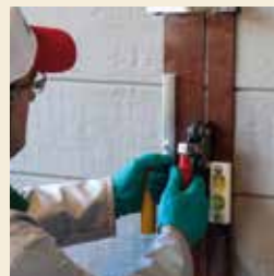
Des outils pour réaliser les joints
