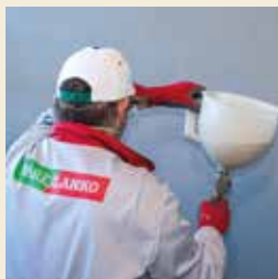
Un pistolet à granulats pour projeter le sable
