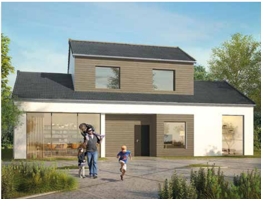
Exemples de lames fines EPICEA sur une maison traditionnelle
